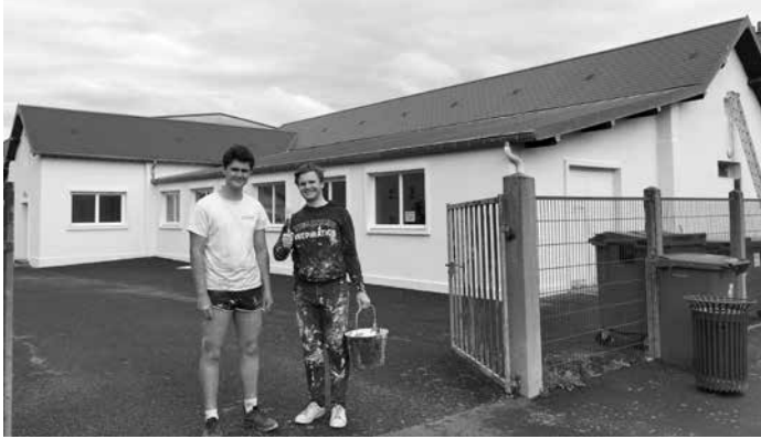
Louis et Marc-Antoine ont effectué des travaux de peinture sur les façades des salles paroissiales de Ste-Thérèse ainsi que sur les menuiseries extérieures.
